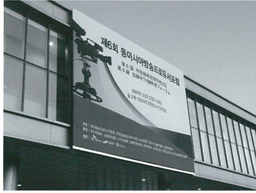
金大中コンベンション・センター
